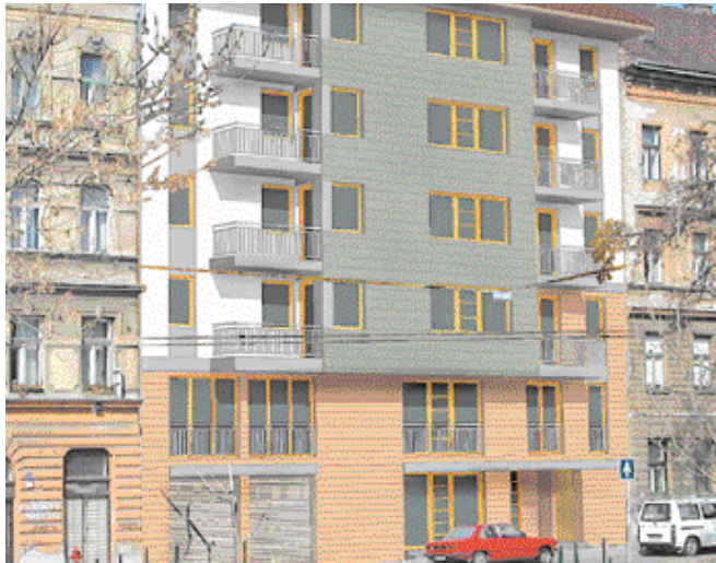
Saniertes Mietshaus in der Budapester Ferencváros
